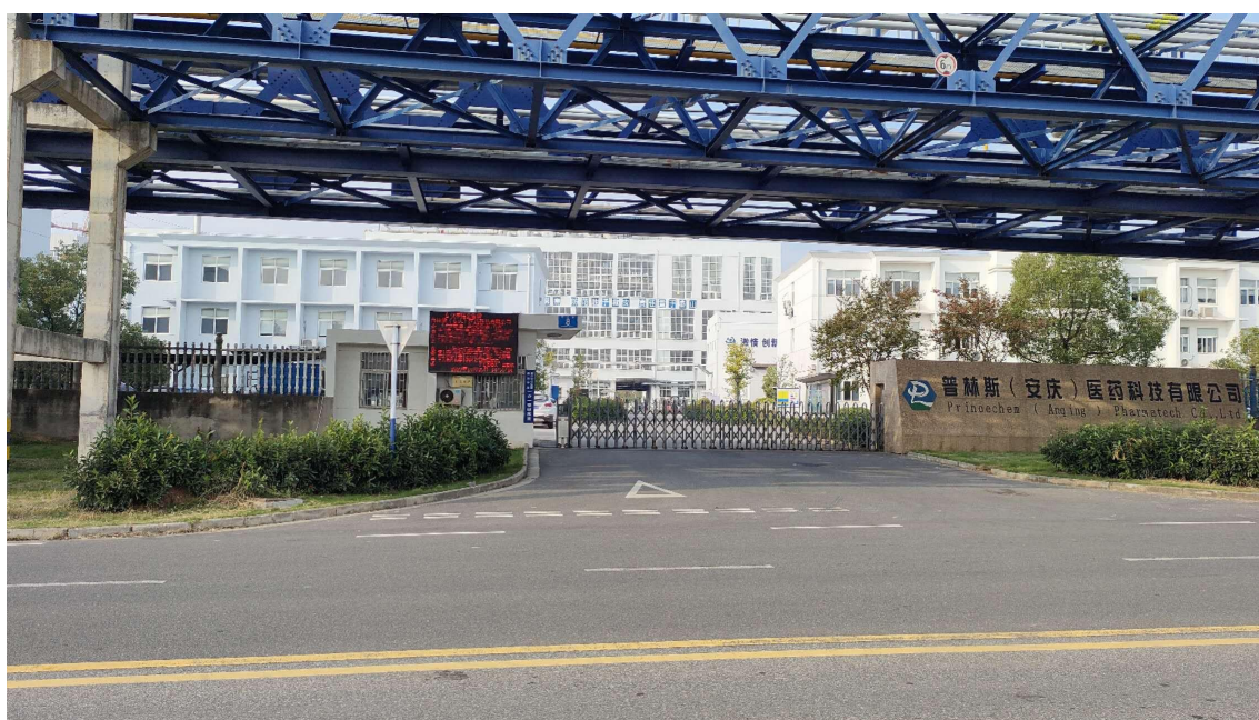
图八.北侧园区管廊及普林斯(安庆)医药科技有限公司
