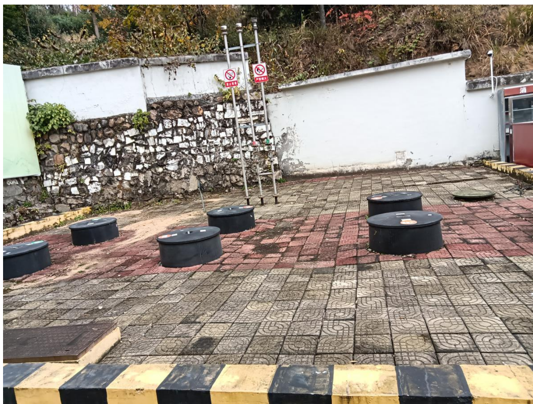
葛蒲加油站罐区照片
