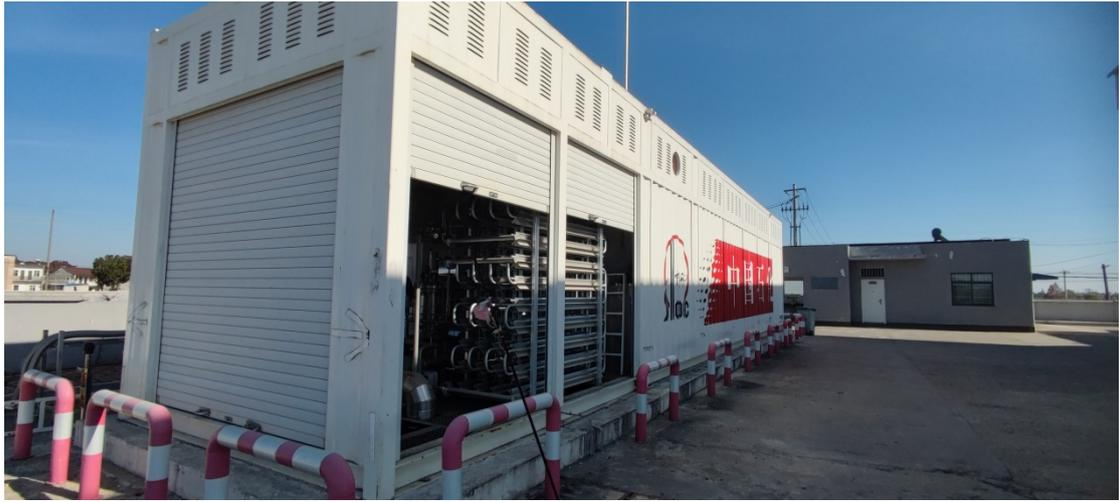
图 6 LNG 撬装加气装置
