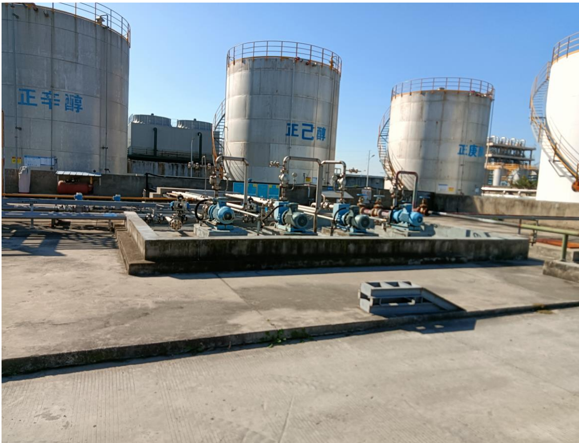
原料罐区现场照片
