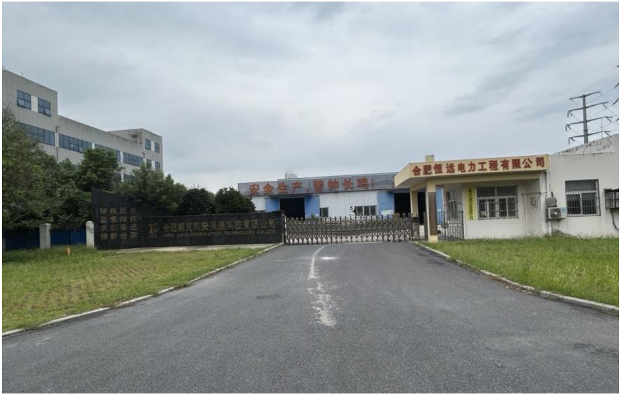
北侧合肥恒远电力工程有限公司
