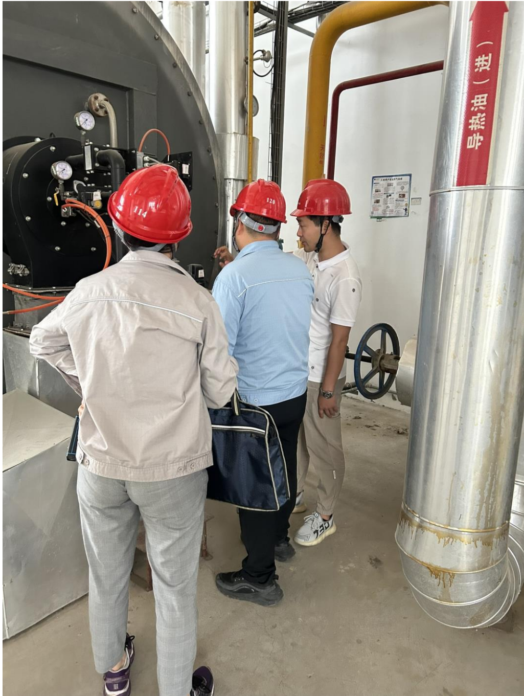
项目负责人、勘验人员和企业专职安全管理人员现场照片
