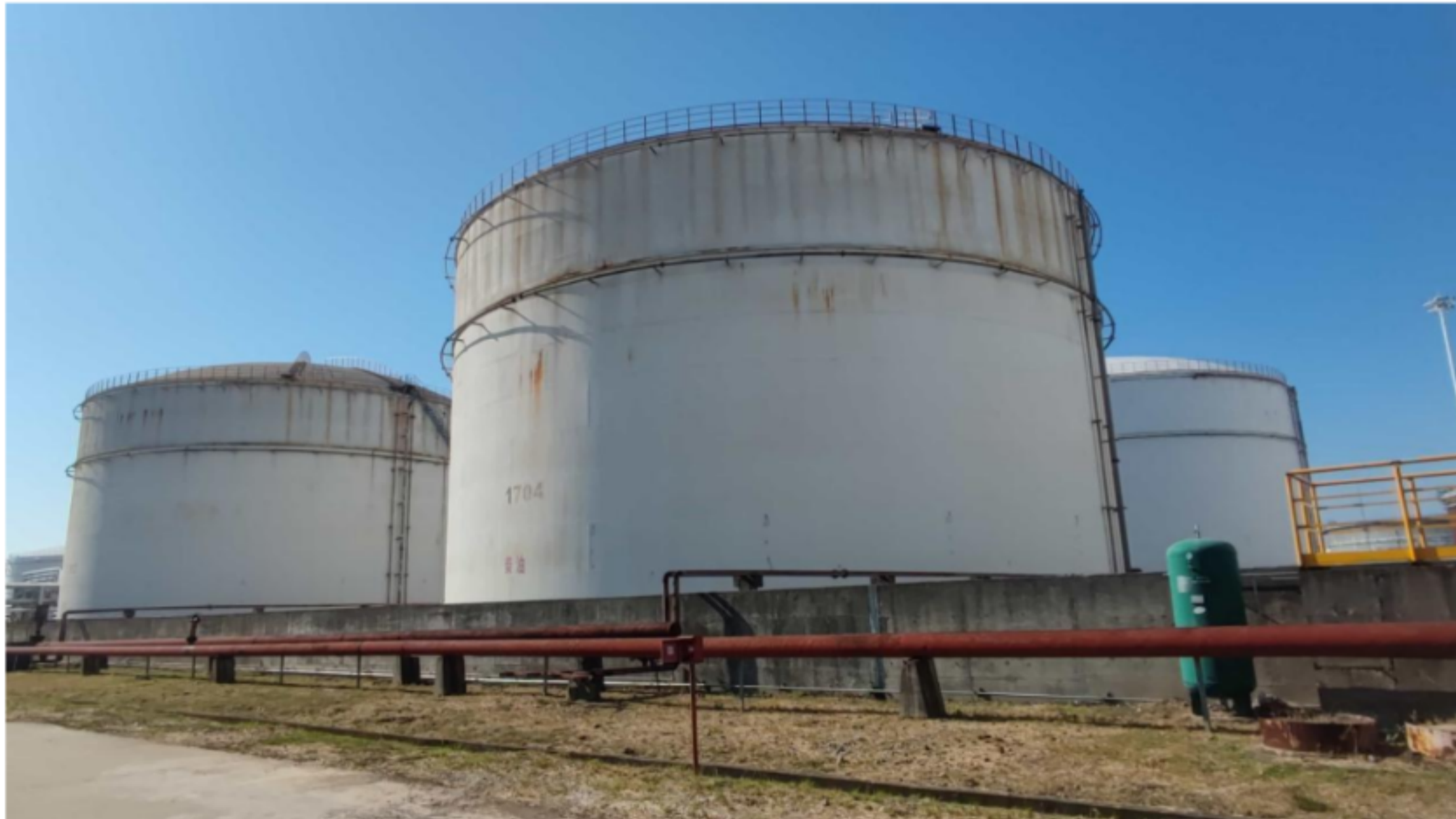
(8) 28 罐组西侧：17 罐组
