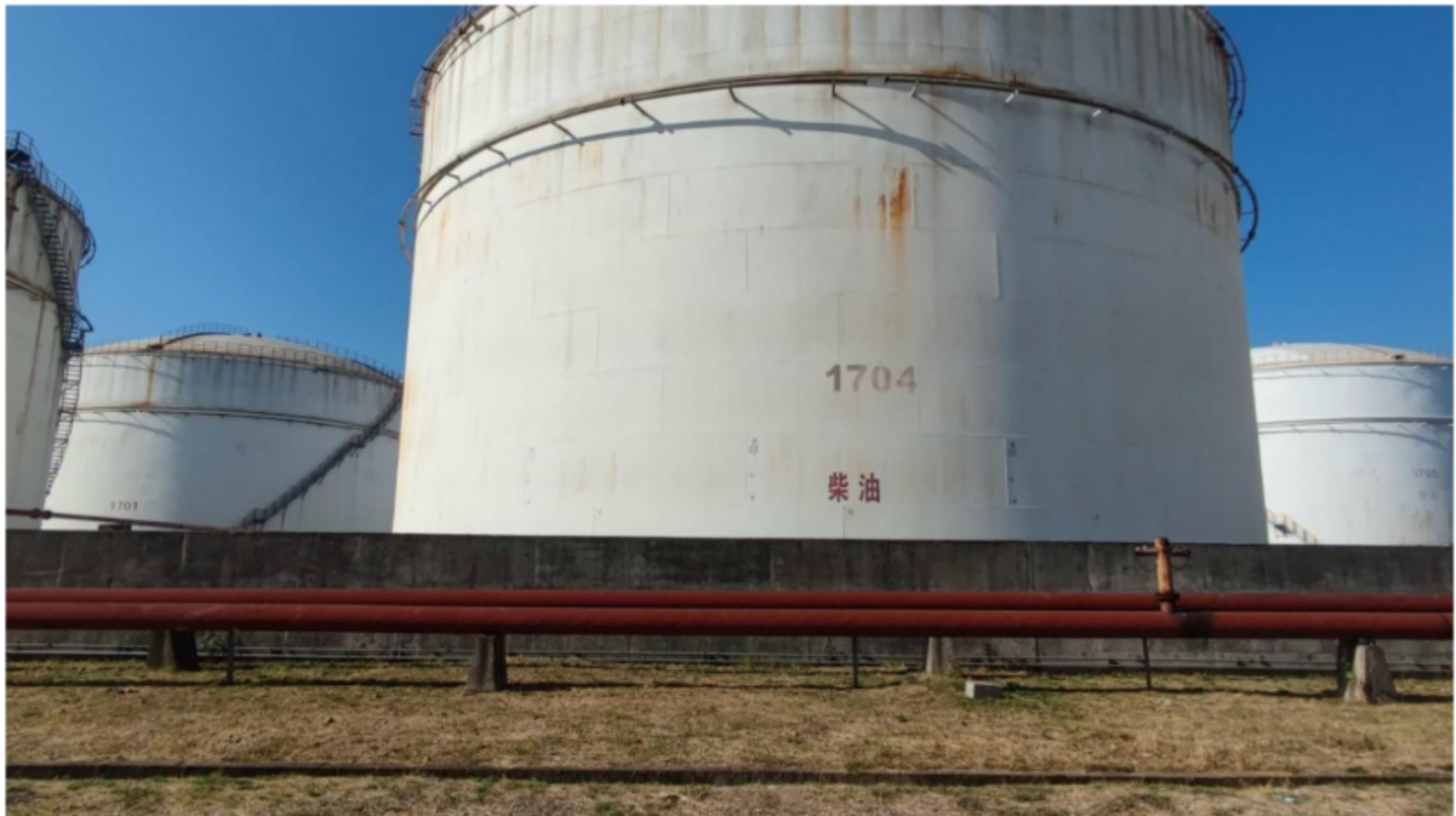
(4) 27 罐组西侧：17 罐组
