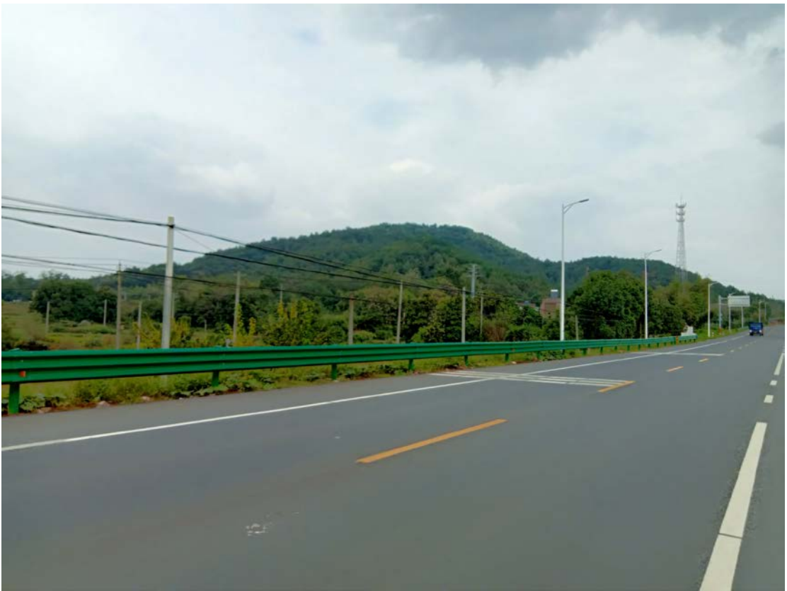
图 3 项目建西侧为 X047 县道、通信线、架空电力线
