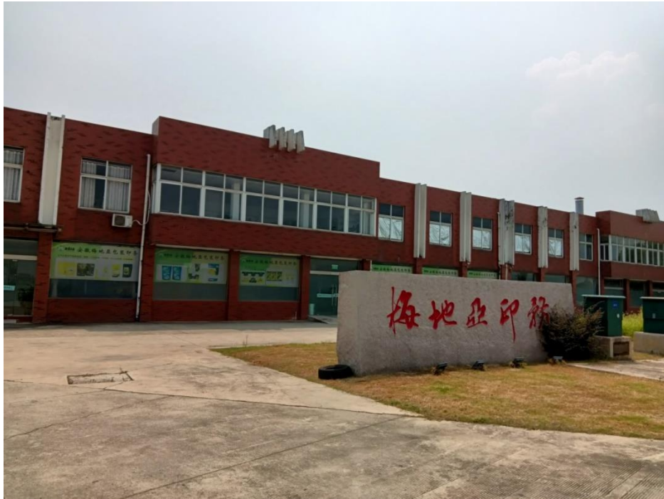
图5 西北侧梅地亚印务公司的办公楼（三类保护物）
