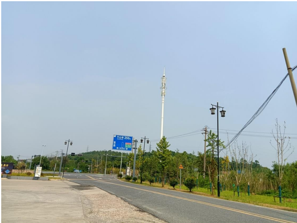
图2 东南侧响水涧公路（次干路、支路）、信号塔（三类保护物）及架空电力线
