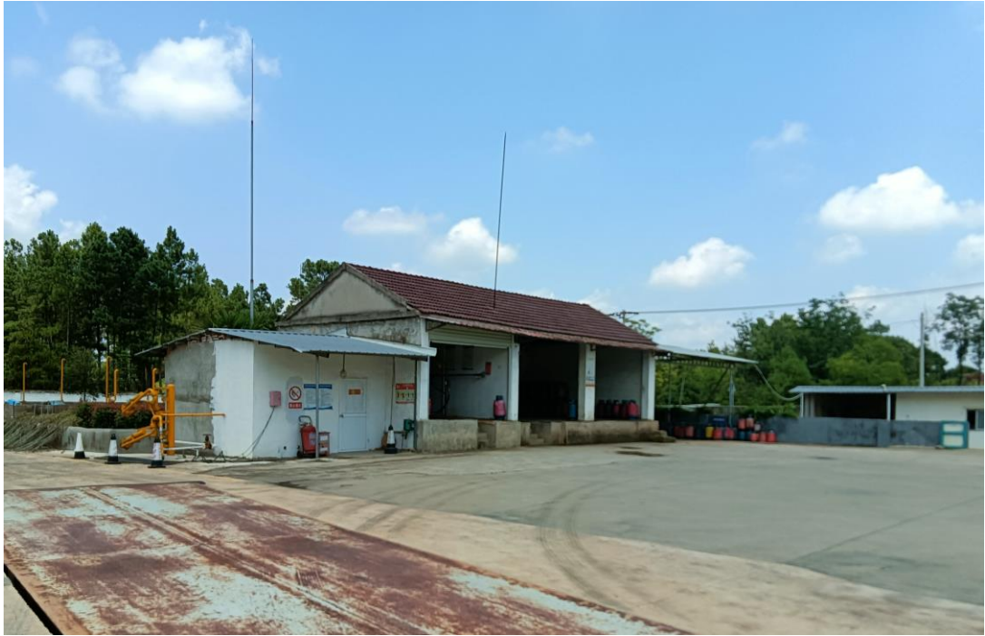
灌装间及压缩机室照片
