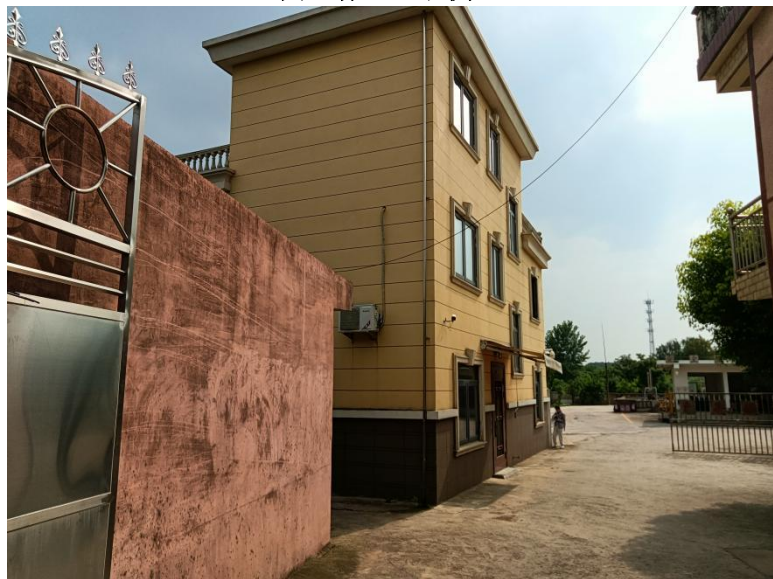
图 6 庐江县龙山液化气站站房
