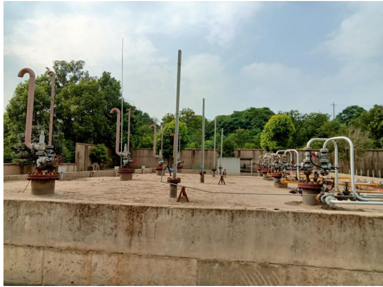
图 7 庐江县龙山液化气站储罐区
