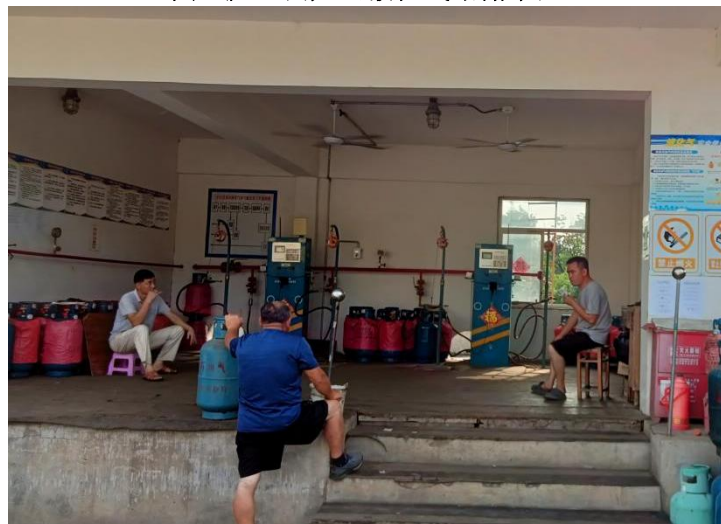
图 8 庐江县龙山液化气站灌装间
