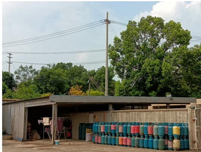
图 2 架空电力线（北侧）
