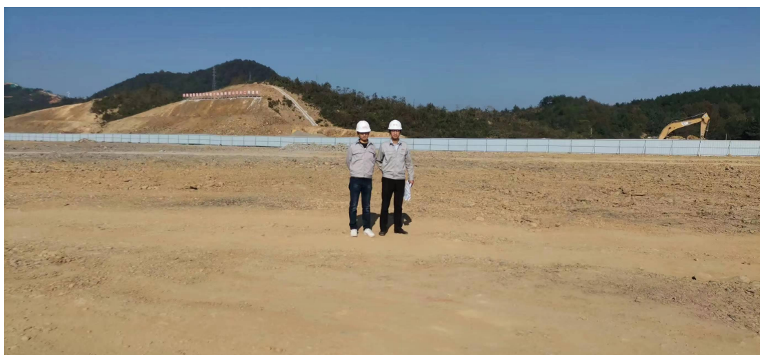
项目现场勘查人员
