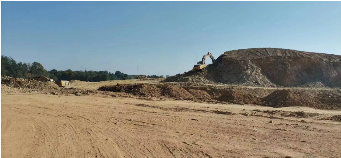
厂区南侧：园区空地及规划中的鹰山路
