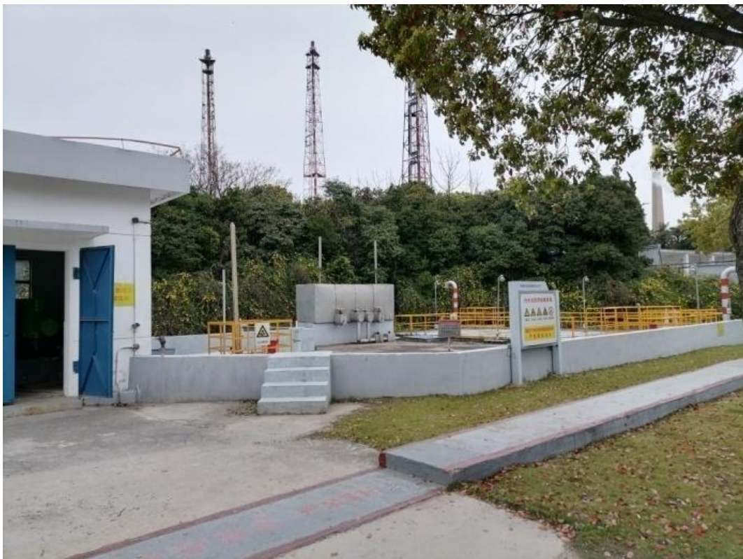
图 16 甬绍金衢首站建北侧含油污水池
