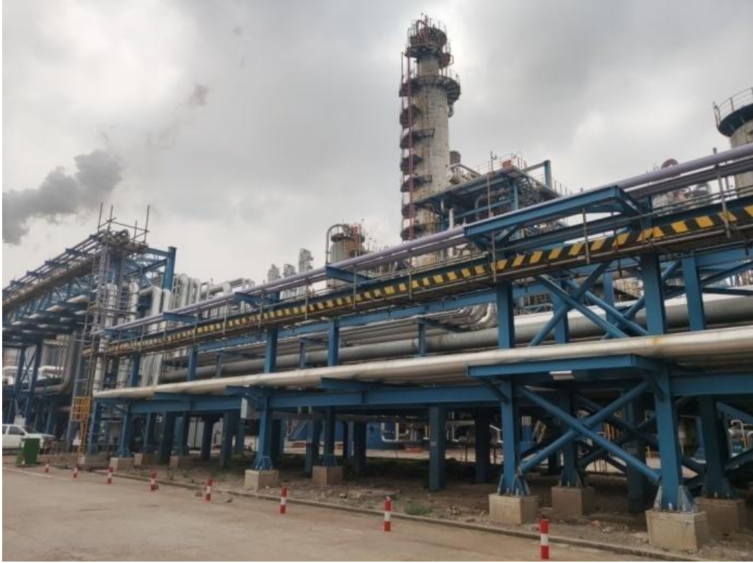
图 13 甬绍金衢首站罐组建南侧Ⅲ加氢
