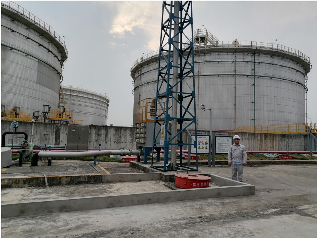
图 25 原现场勘查人员操辉（2021.6.4）现场照片
