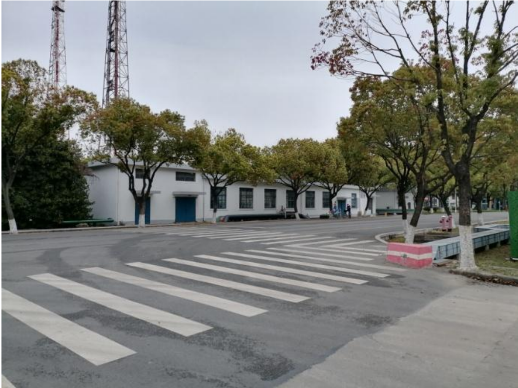
图 17 甬绍金衢首站建北侧纬二路
