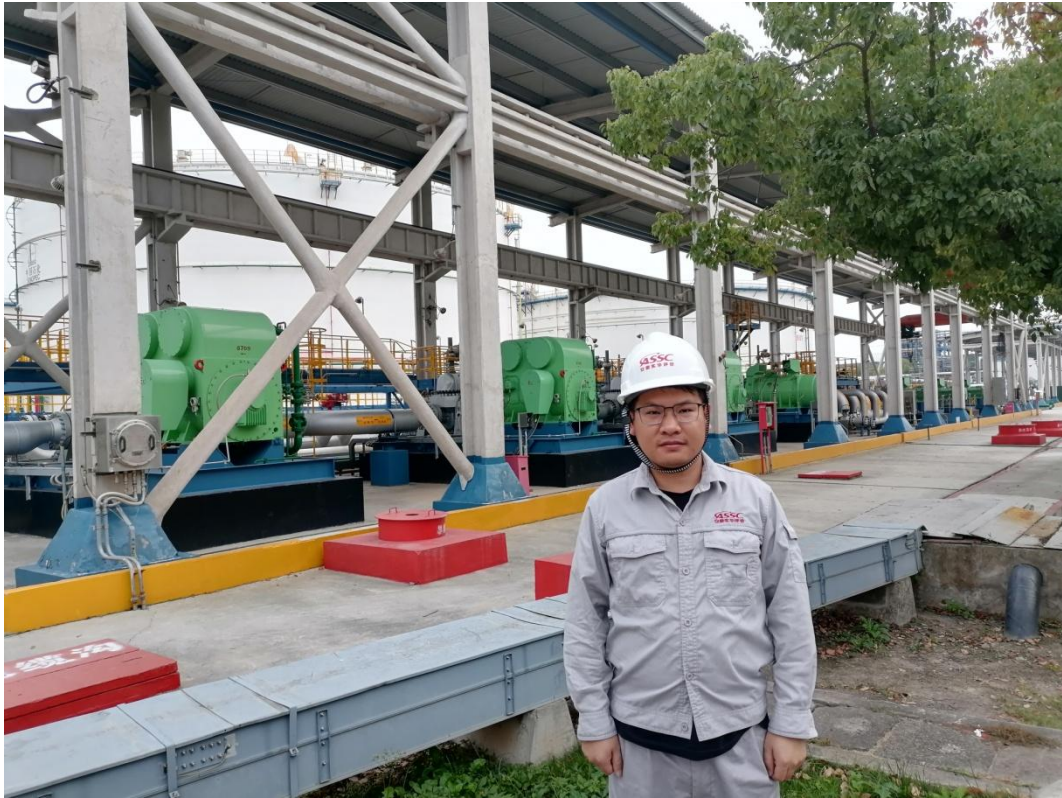
图 27 现场勘察人员伍宇（2023.3.29）现场照片
