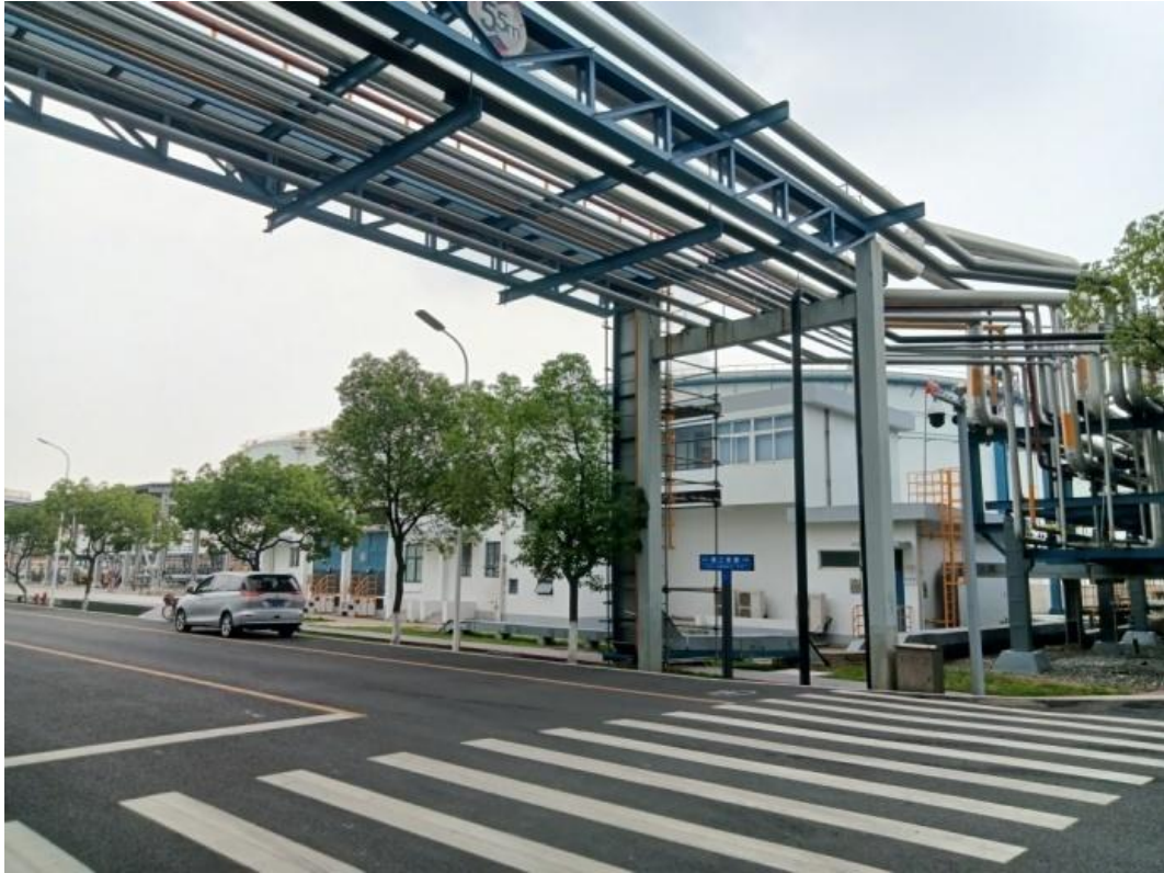
图 9 甬绍金衢首站罐组建北侧倒罐泵棚和罐组配电室
