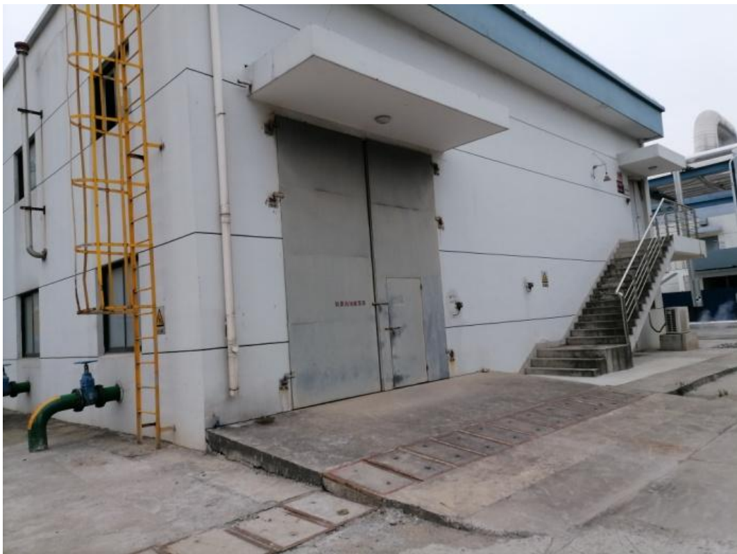
图 4 原油罐组低压配电室及泡沫站
