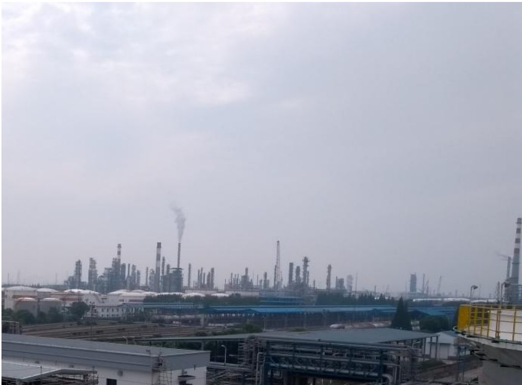
图 22 9#原油罐组、配电室及泡沫站建西侧厂内铁路
