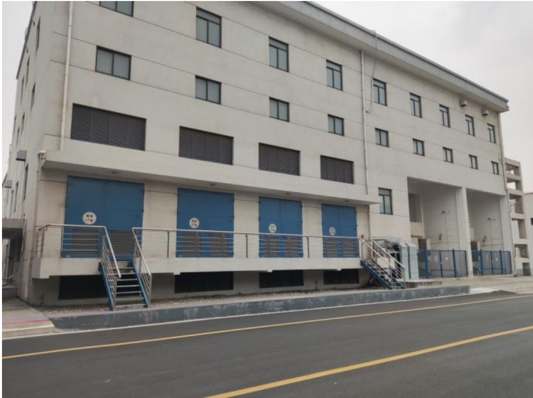
图 3 35kV 区域变电所及机柜间
