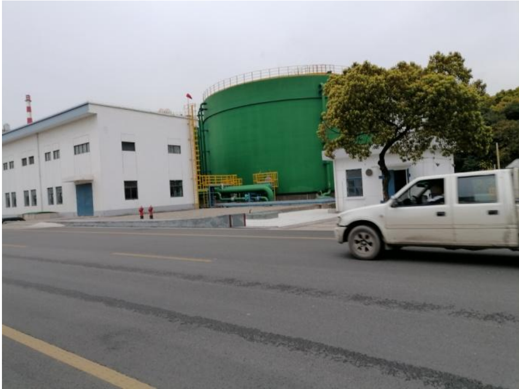
图 15 甬绍金衢首站建北侧消防泵房
