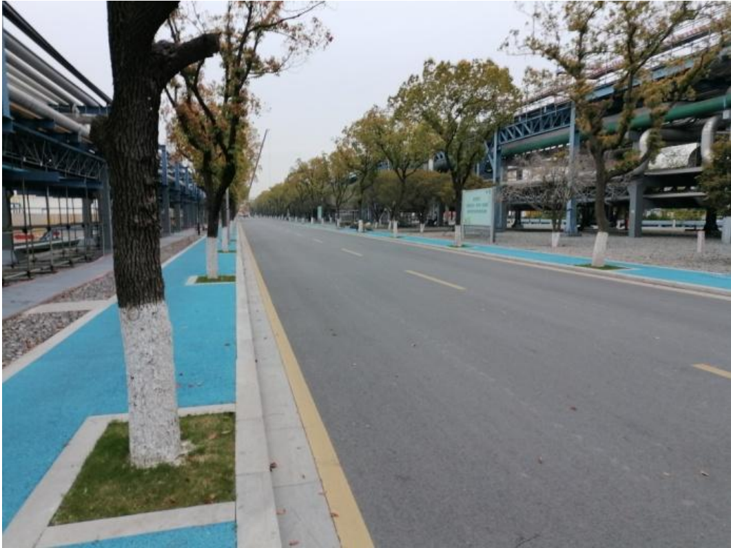
图 11 甬绍金衢首站罐组建西侧管廊和经七路
