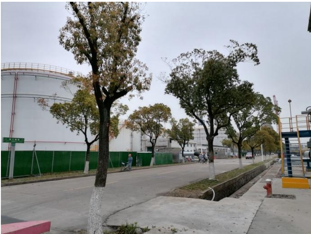
图 6 甬绍金衢首站罐组建东侧混二甲苯罐、蜡油罐和经八路
