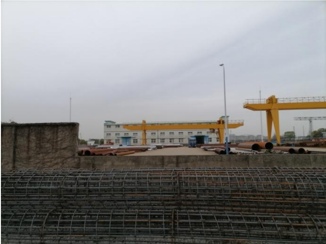
图 21 9#原油罐组、配电室及泡沫站建南侧全厂公用仓库
