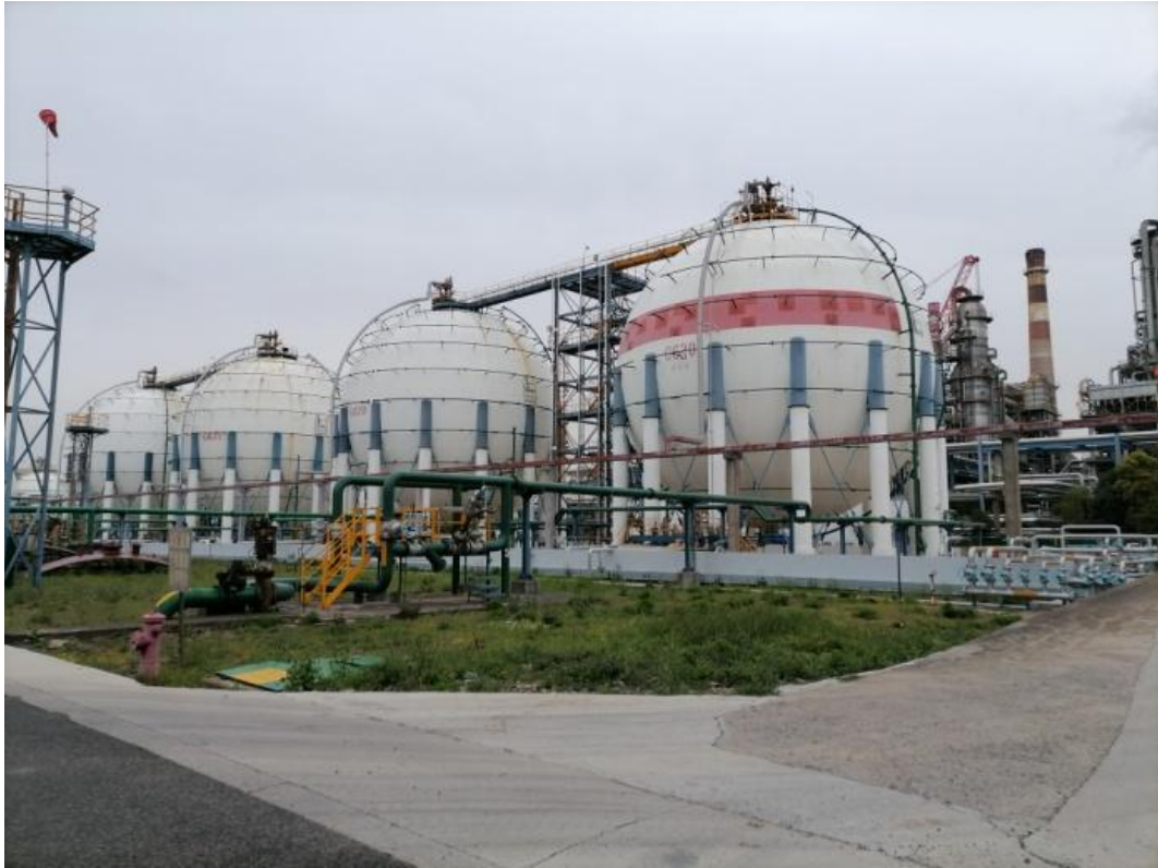
图 23 9#原油罐组、配电室及泡沫站建北侧轻石脑油球罐区
