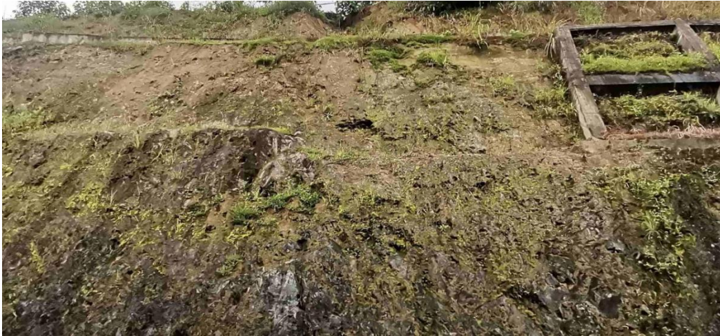
华恒加油站东侧山体
