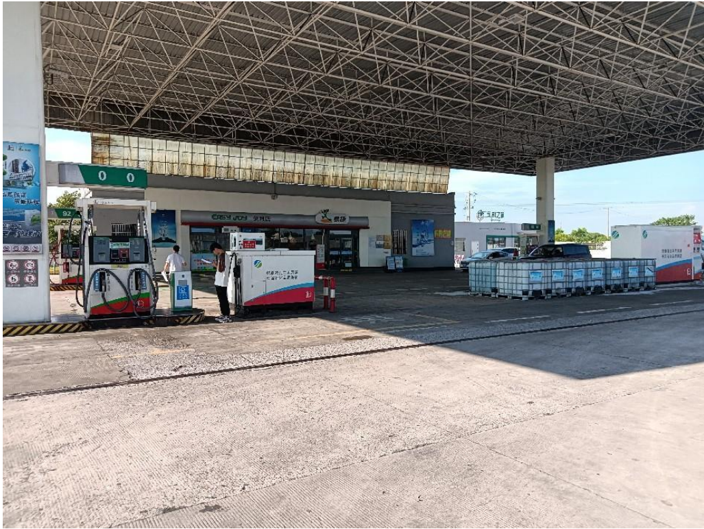
箱式 LNG 撬装建北侧为加油区，加油区件建北侧站外有架空电力线路（有绝缘层，杆高 12m）
