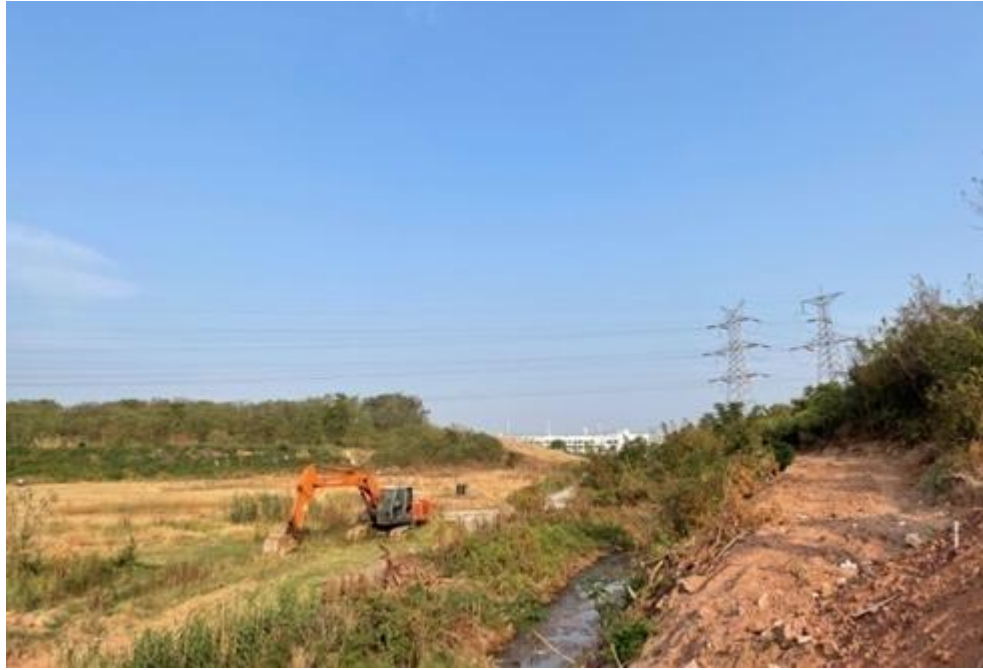
厂区东侧：园区空地及 110kv 安铜 454 高压走廊线
