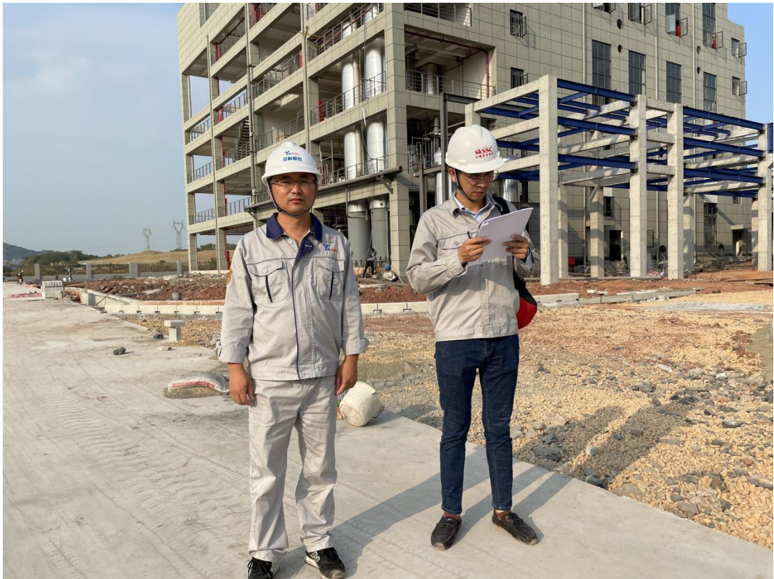
项目现场勘查人员
