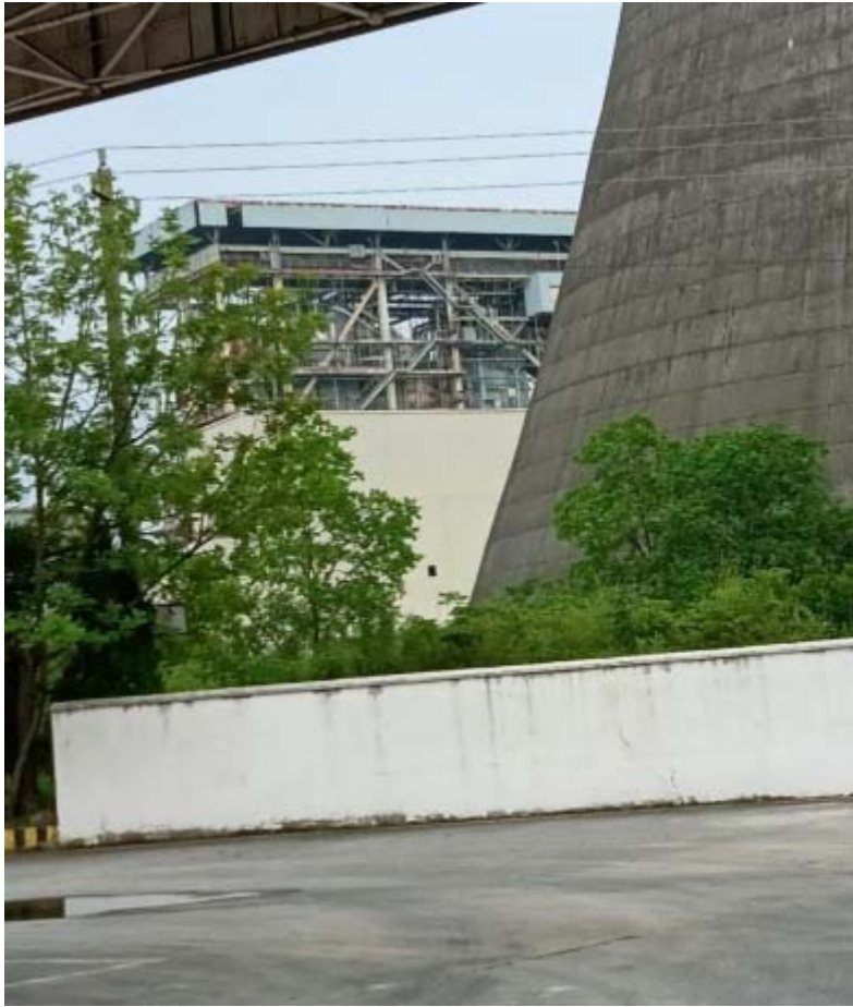
加油站东南侧架空电力线路
