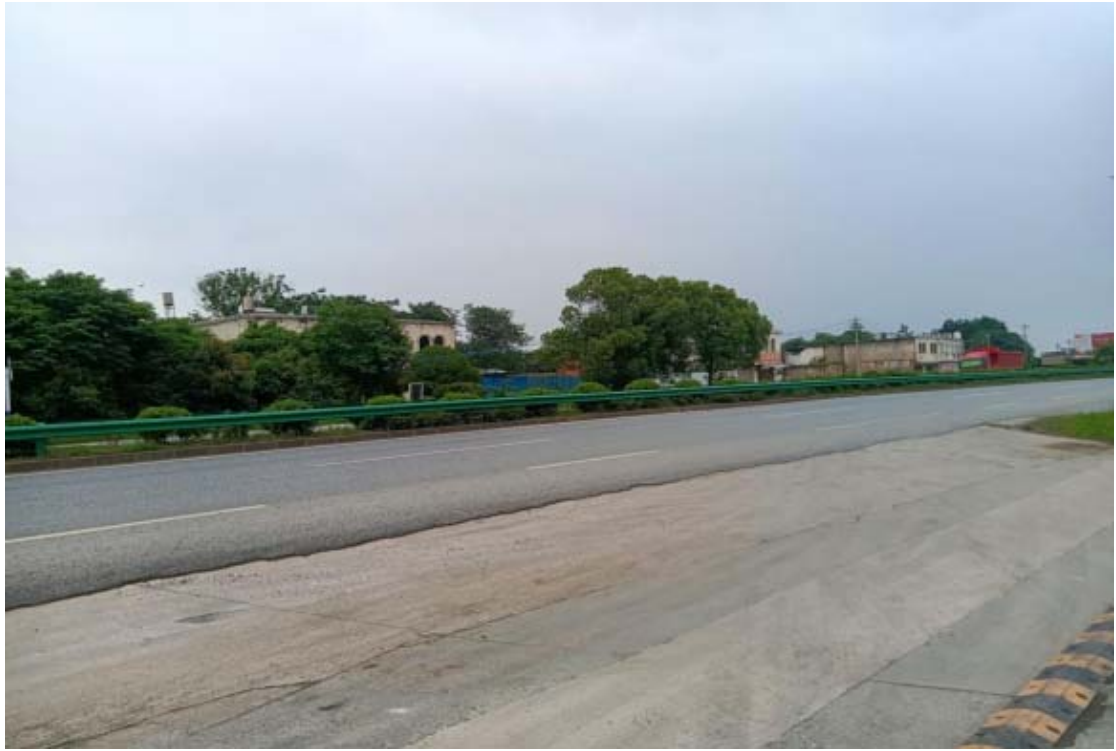
加油站北侧 460 省道
