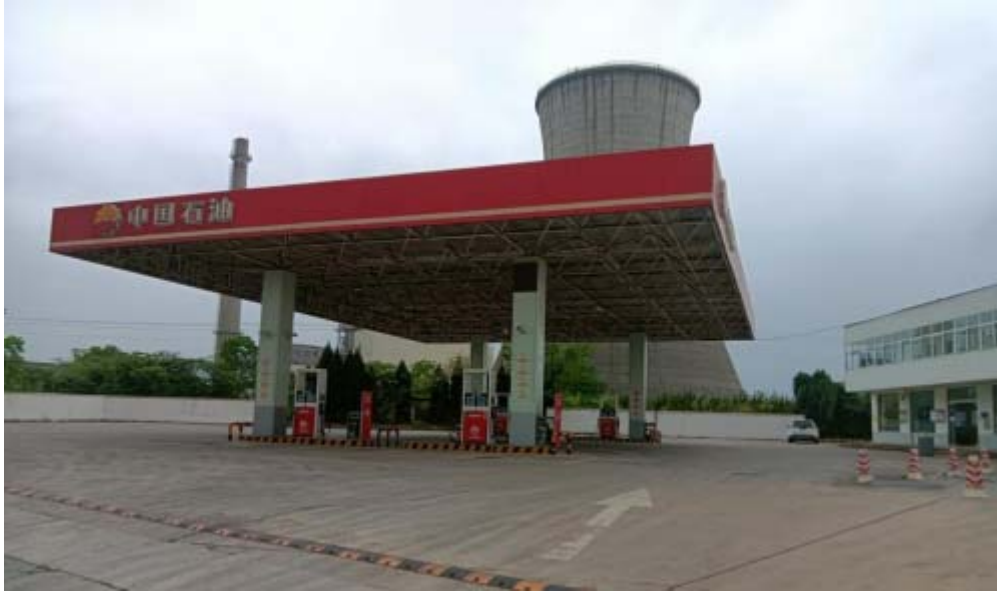
加油站整体照片
