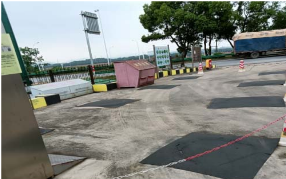
加油站罐区照片
