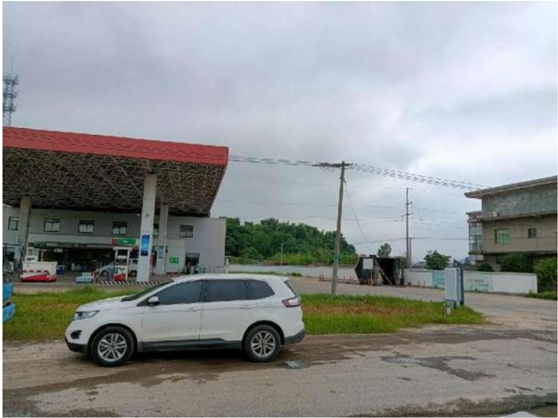
省道和加油站之间（靠近加油站一侧）有架空电力线路
