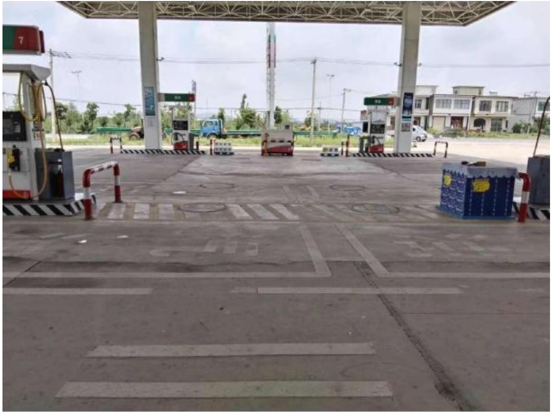
金牛加油站罐区照片
