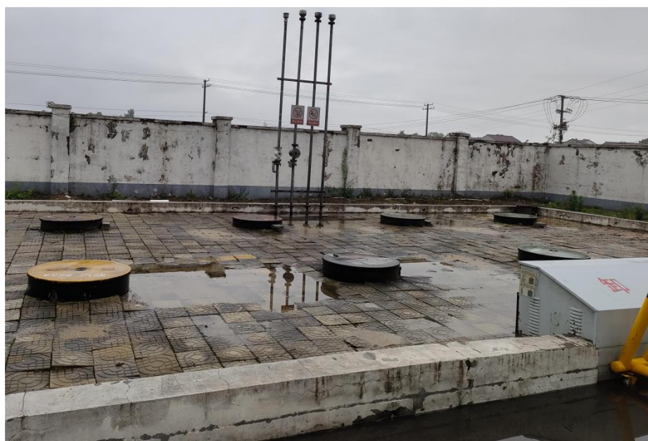
三桥加油站罐区照片
