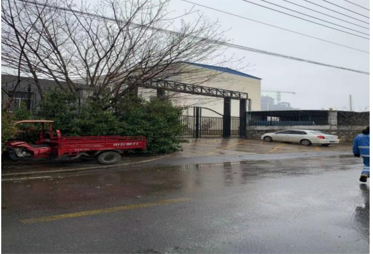
厂区东侧：丹桂路，路东架空电力线及安庆飞凯新材料有限公司
