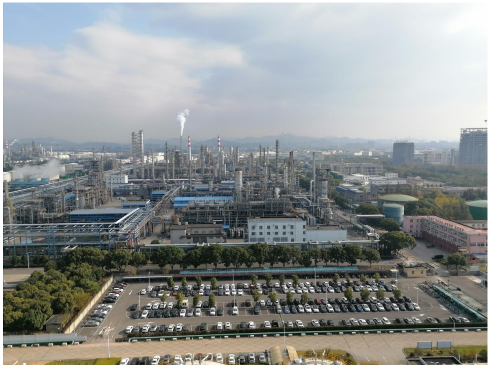
3#、4#和 5#空分装置建南面为厂外道路，隔路为小车停车场、镇海炼化变电所、柴油加氢装置、重整装置
