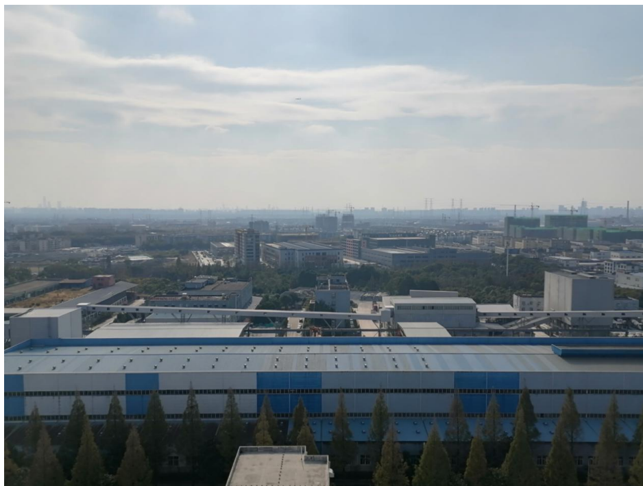
3#、4#和 5#空分装置建西面为宁波蛟川构件有限公司
