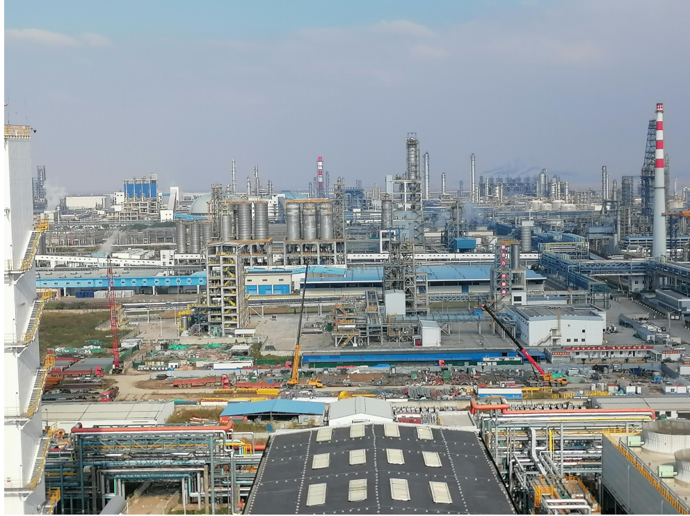
3#、4#和 5#空分装置建东面为中石化宁波新材料研究院中试装置区
