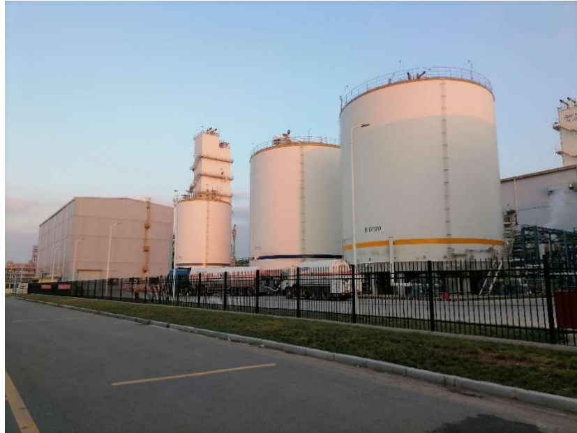
4#和 5#空分储罐区
