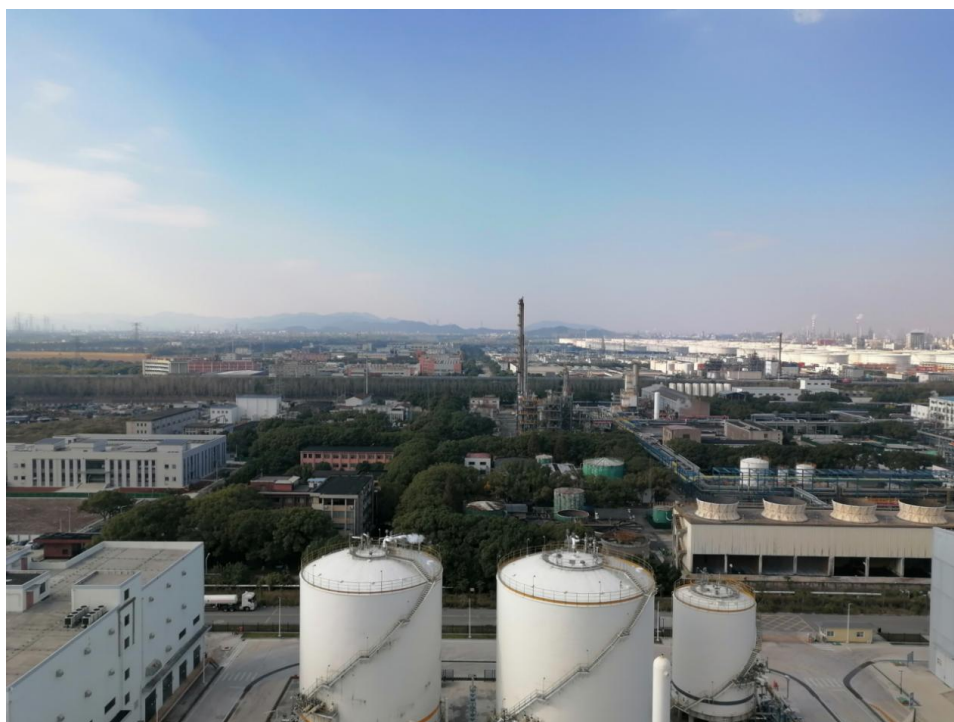
3#、4#和 5#空分装置建北面为镇海炼化氢能制造部
